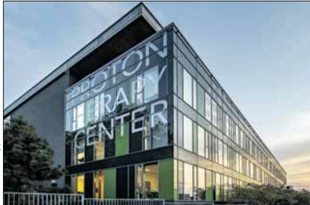
Budova pražského Protonového centra.
